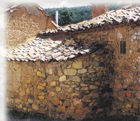
Casa con hornera en Rioseco de Tupia
