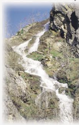
Aliviadero de la central hidroeléctrica
